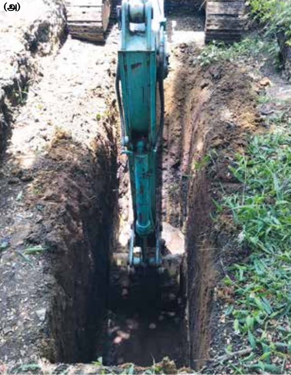
அ) PRB பொருள்களை நிறுவுவதற்கான நிலத்தடி நீர்ப் பாய்வுப் பாதைக்குக் குறுக்கான அகழி அகழ்வு (1 மீ அகலம், 5 மீ ஆழம், 60 மீ நீளம்), சுந்தரபொல குப்பைமேடு, குருணாகல், இலங்கை
