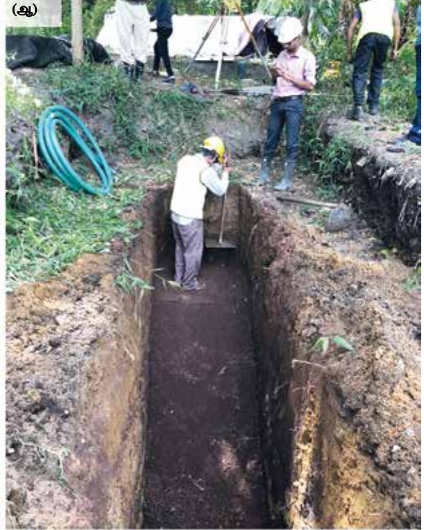
ஆ) PRB பொருள்களால் (உயிர்க்கரி + செங்கல் துண்டுகள் + அடர் களி) அகழியை நிரப்புவதும் நிறுவுதலை முடிப்பதற்காக இறுக்குதலும்
