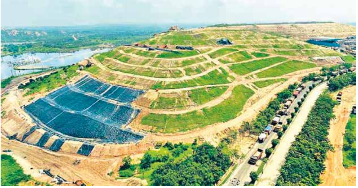
படம் 9.1 ஹைதராபாத்திலுள்ள 135 ஏக்கர் ஜவஹர்நகர் குப்பைமேட்டிற்குக் காப்புறை அணிவித்தல் (ஆதாரம்: CSE, 2020)
