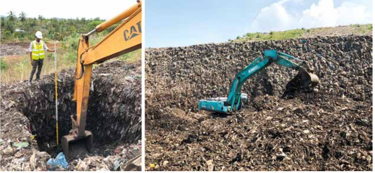
படம் 6.2 சோதனை அகழ்வாராய்ச்சிகள் மூலம் குப்பைமேட்டு அகழ்வின் சாத்தியத்தை மதிப்பீடுதல்
